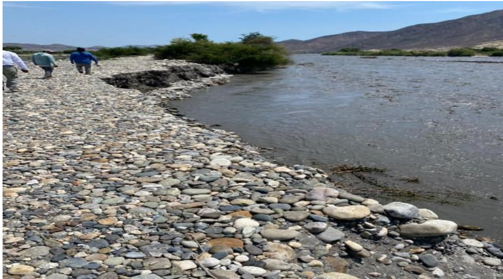
FIGURA N°02: VISTA DE LA EROSION EN LA CARA HUMEDA DEL DIQUE DE LA MARGEN IZQUIERDA DEL RIO - SECTOR LA CANTERA I, REQUIERE PROTECCION CON ROCA AL VOLTEO, EN UN TRAMO DE 100 ml.
